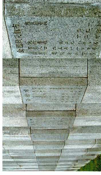
側柱に刻まれた被災記録
